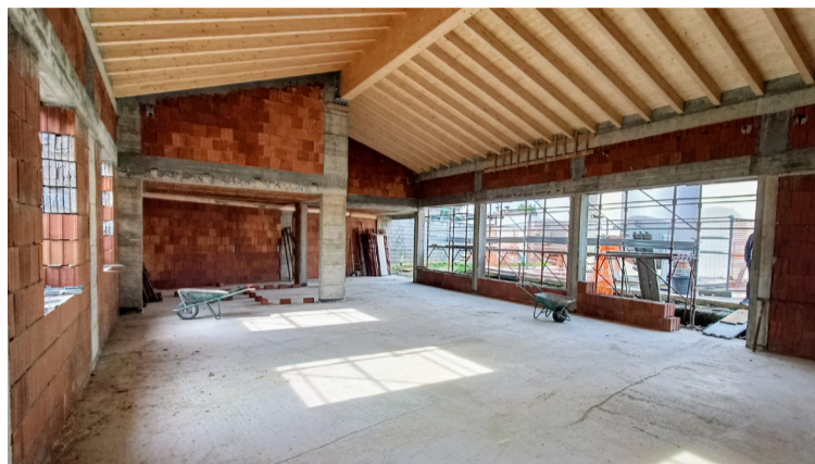
Lavori per la costruzione della struttura polifunzionale
